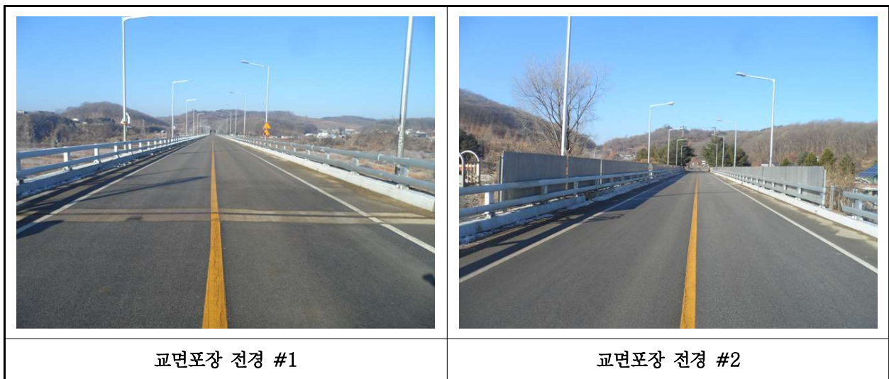
【사진 3.23】 교면포장 전경
