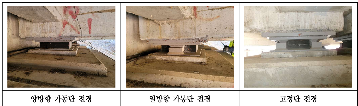
【사진 3.16】 교량받침 전경
