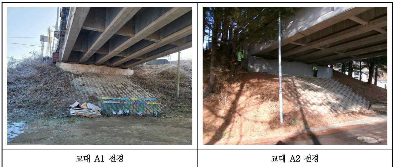
【사진 3.10】 교대 전경
