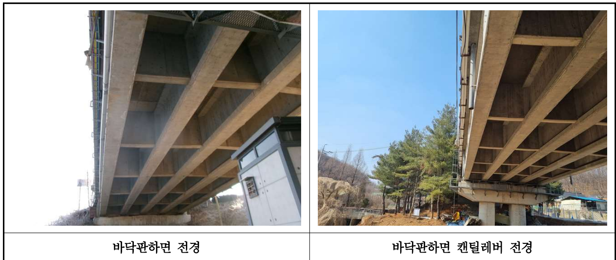
【사진 3.4】 바닥판하면 전경
