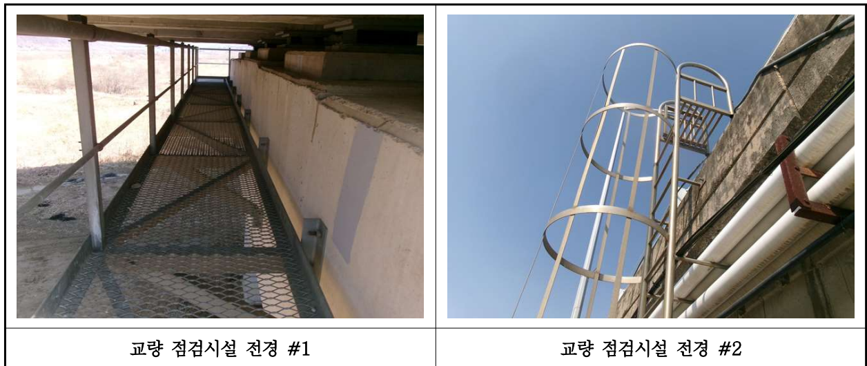
【사진 3.29】 교량 점검시설 전경
