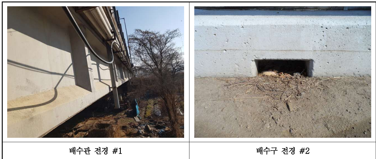
【사진 3.25】 배수시설 전경
