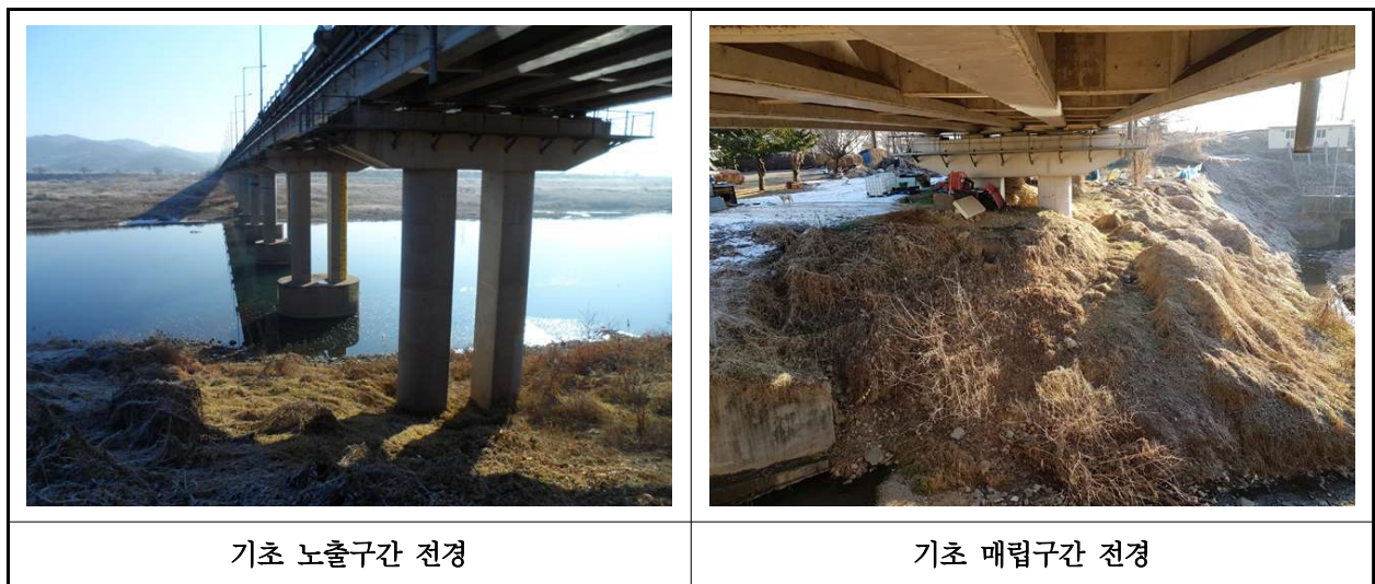
【사진 3.14】 기초 전경
