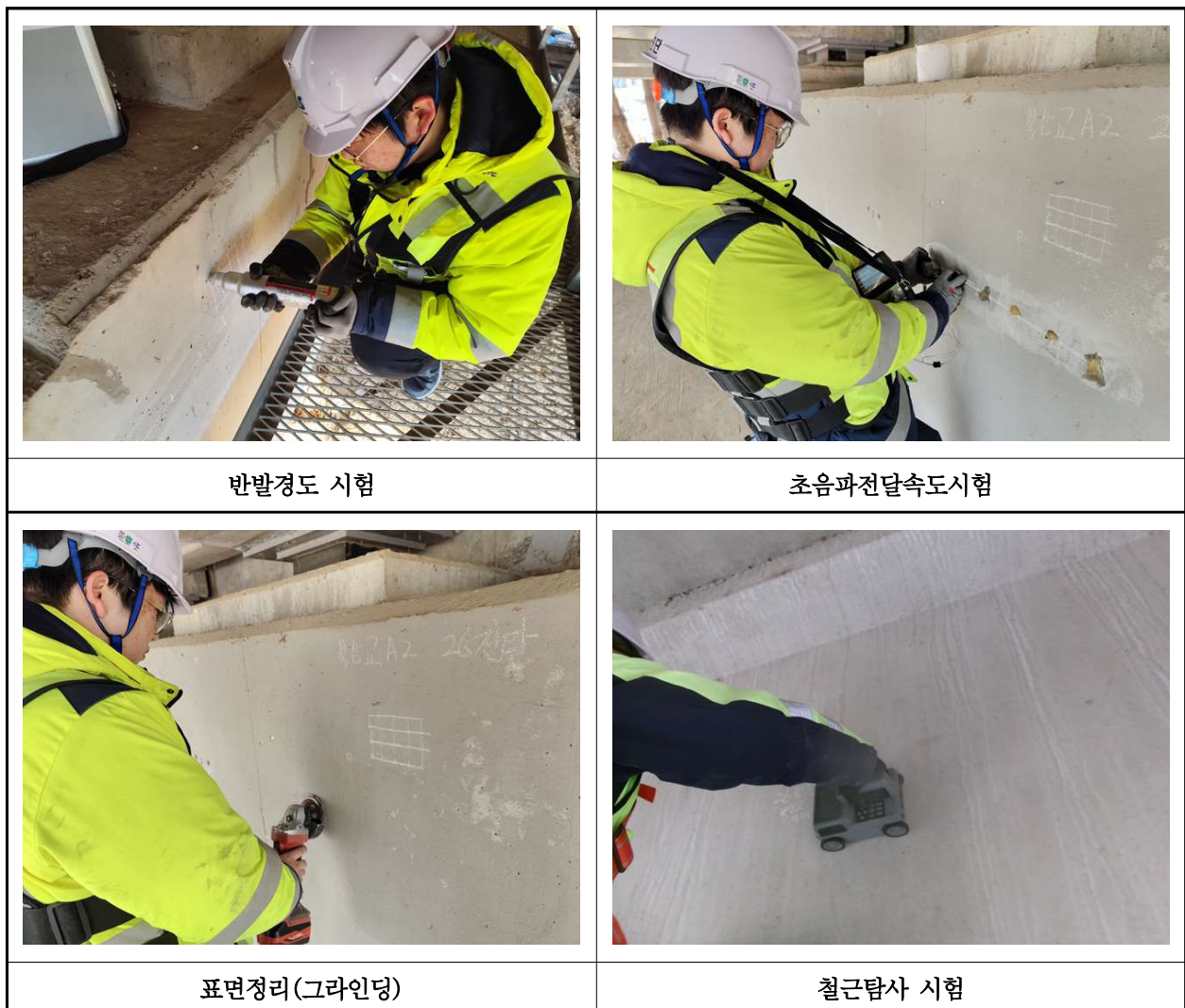
【사진 3.35】 콘크리트강도 시험 현장사진
