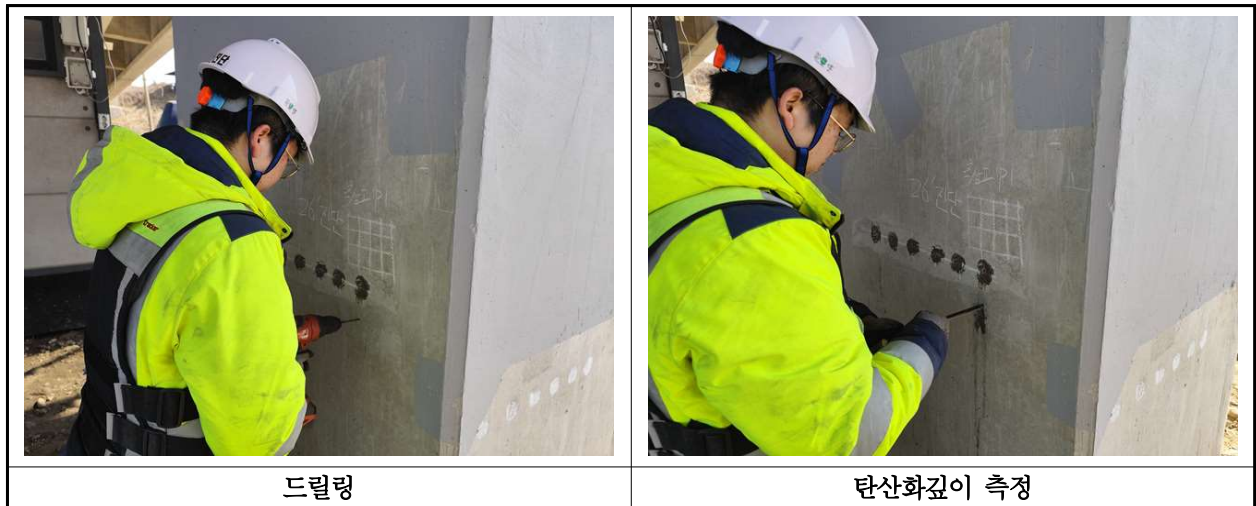
【사진 3.37】 탄산화 깊이 측정 현장사진
