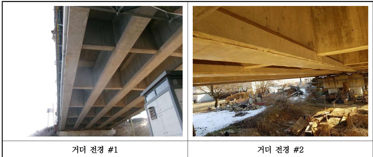
【사진 3.6】 거더 전경
