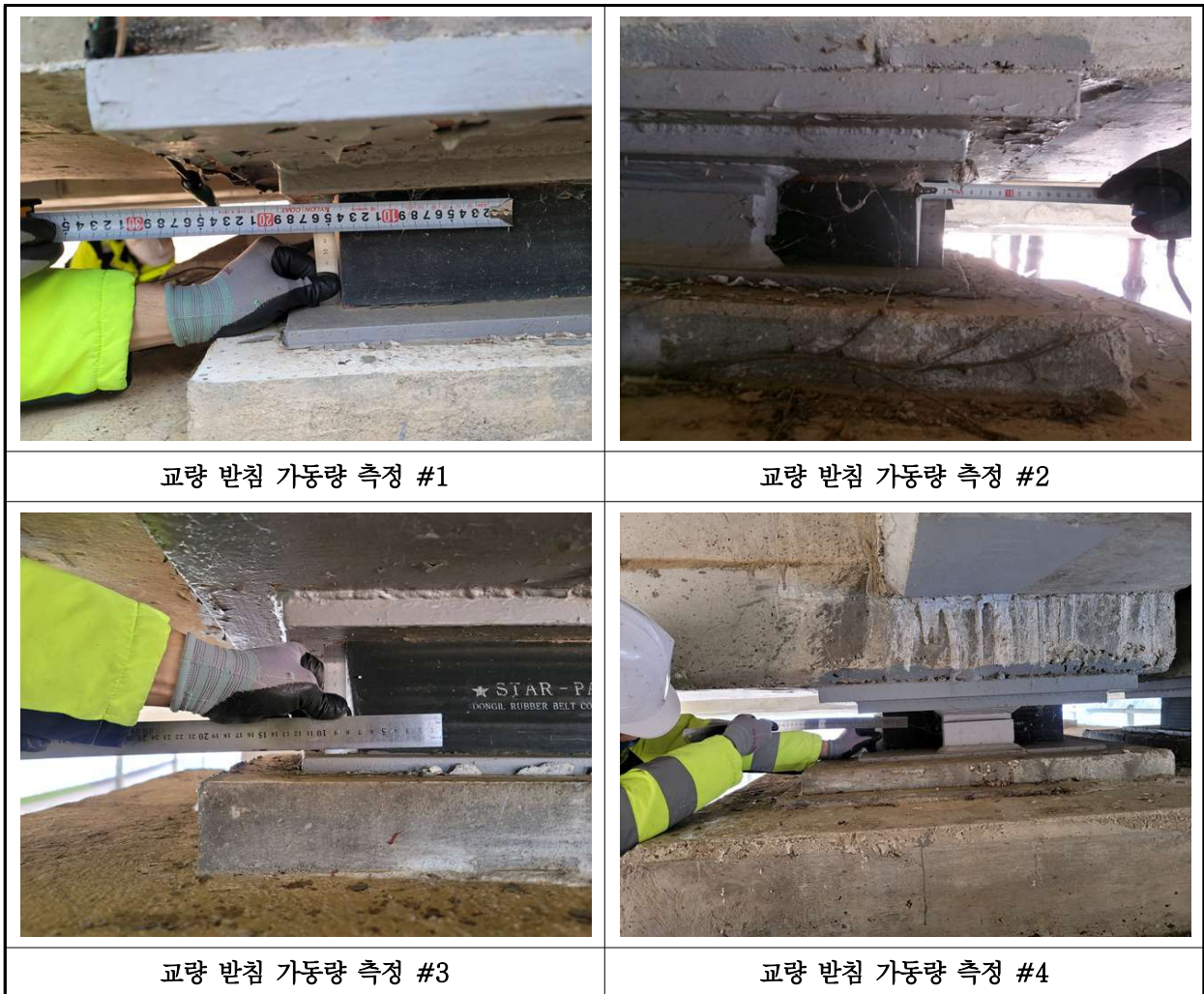
【사진 3.19】 교량받침 이동량 측정
