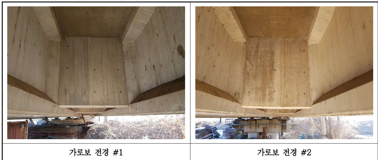
【사진 3.8】 가로보 전경
