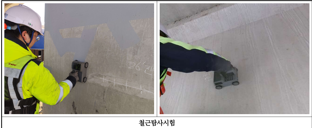
【사진 3.36】 철근탐사시험 현장사진
