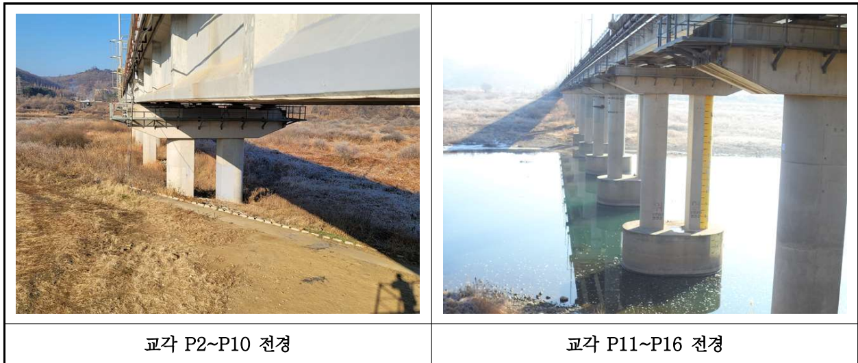
【사진 3.12】 교각 전경
