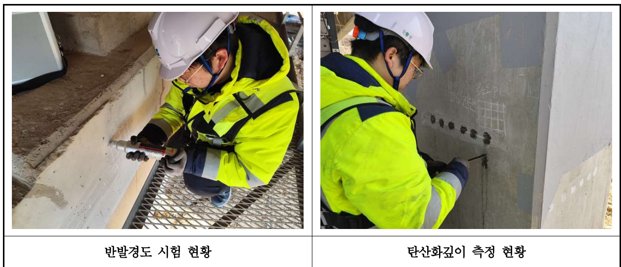
【사진 3.34】 콘크리트 내구성조사 현황
